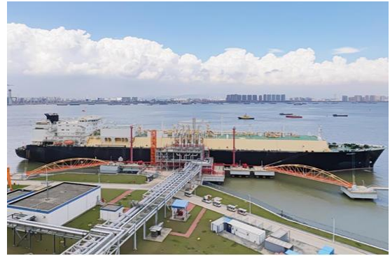
图:广州 LNG 应急调峰气源站成功接卸液化天然气船“特雷德”号。
